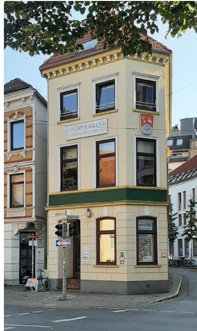
Chorverbandshaus in Bremen
